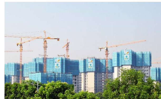
SSGF项目实景
